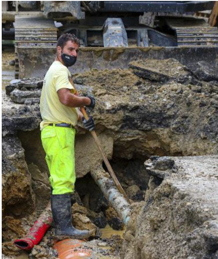
Al centro, lavori a un conduttura idrica. In alto, Stefano Alvisi
